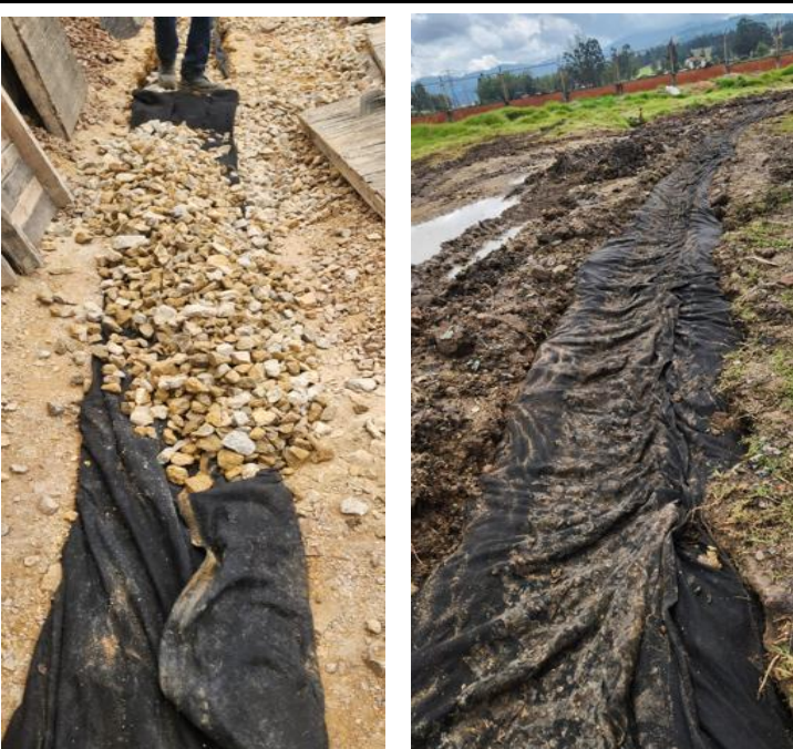
FOTO 3: AMARRE DE GEOTEXTIL
