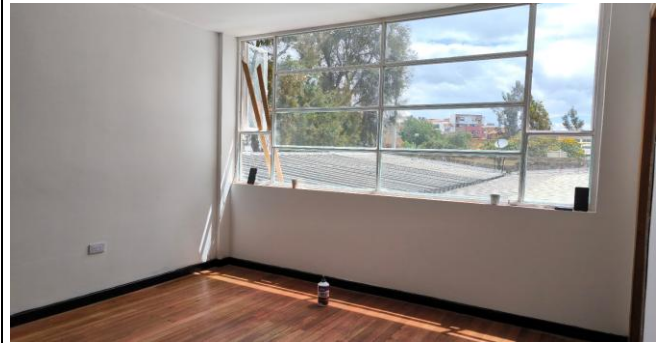
FOTO 2: Instalación de ventanas
