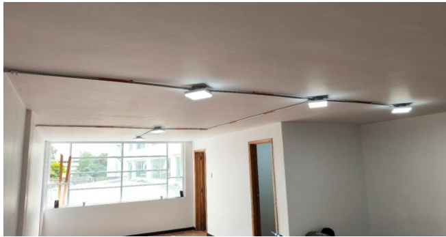
FOTO 3: Suministro e instalación de panel led cuadrado.
