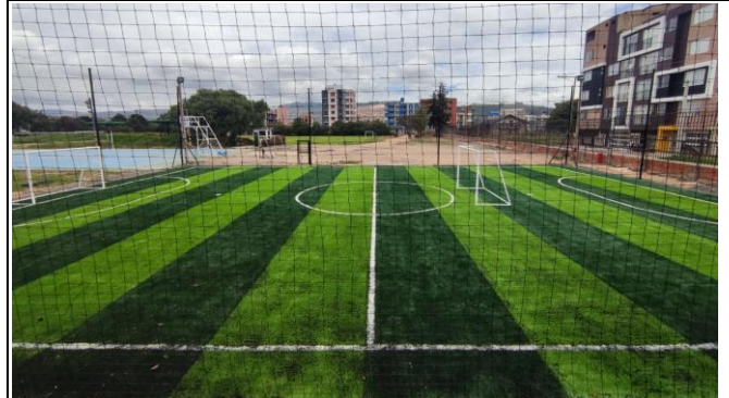
FOTO 6: Grama sintética, porterías y malla de cerramiento
