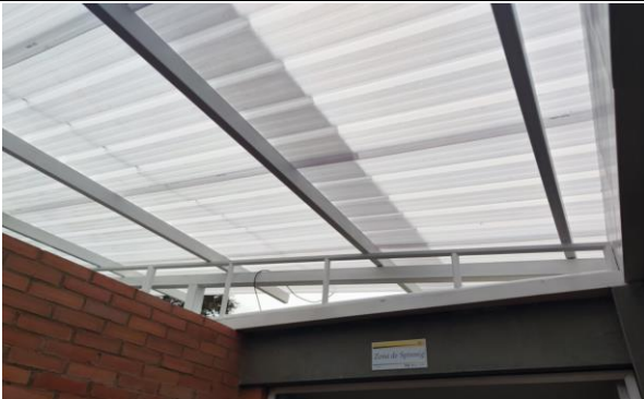
FOTO 5: Instalación de estructura metálica y cubierta en la entrada del gimnasio
