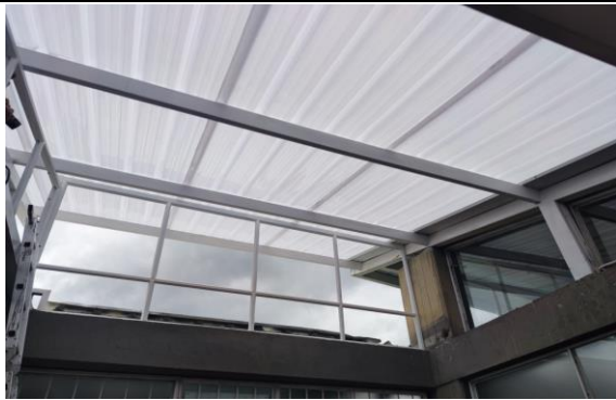
FOTO 3: Instalación de estructura metálica y cubierta en la entrada del gimnasio
