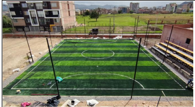
FOTO 4: Instalación de la grama sintética
