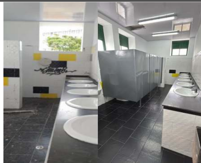
FOTO 2: Resultados del mejoramiento baños edificio central 2do piso
