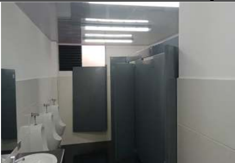
FOTO 1: Cielo raso en PVC
