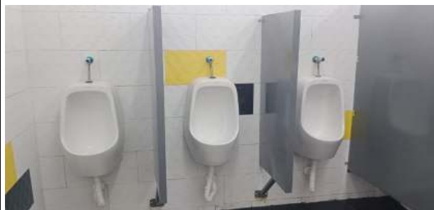
FOTO 4: Resultados de instalación de elementos sanitarios, edificio central
