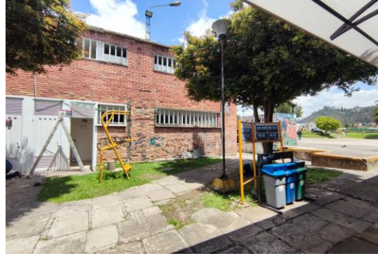
FOTO 2: Condiciones iniciales del lugar a intervenir
