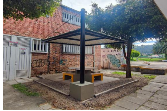
FOTO 4: Quiosco construido y entregado a la seccional Duitama
