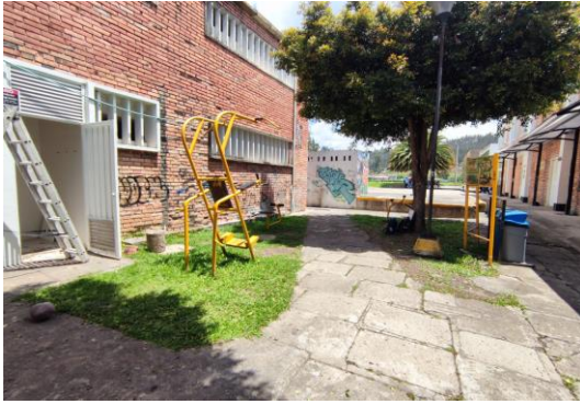
FOTO 1: Condiciones iniciales del lugar a intervenir
