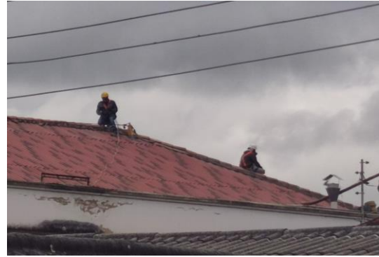
FOTO 4: Cambio de cubiertas edificio central
