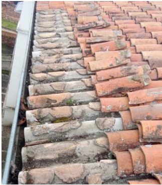
FOTO 3: Reinstalación de teja de barro en cubiertas de la sede de salud
