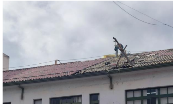
FOTO 2: Cambio de cubiertas en el edificio central
