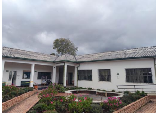
FOTO 6: Mantenimiento de cubiertas edificio de bienestar universitario
