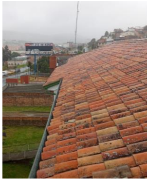
FOTO 3: Reinstalación de teja de barro en cubiertas de la sede de salud
