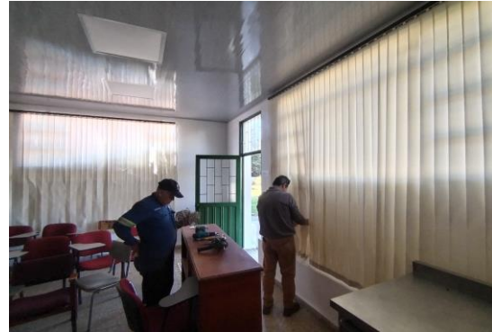
FOTO 2: Aula S-107 Pavimentos - Condición final
