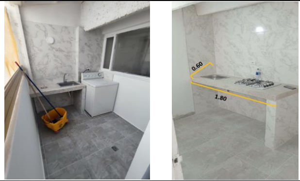
FOTO 4: Upetecitos patio y cocina - Condición final
