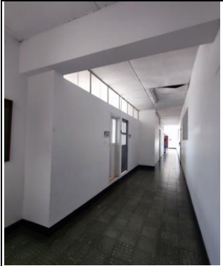
FOTO 5: Condiciones iniciales pasillo piso 2
