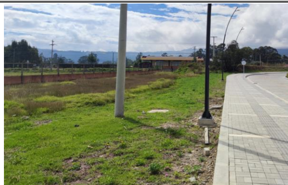
FOTO 1: Condición inicial del sitio intervenido
