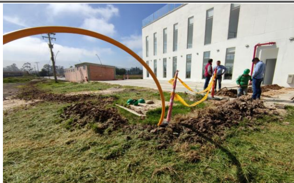
FOTO 2: Trabajos de instalación de tubería PE 2"
