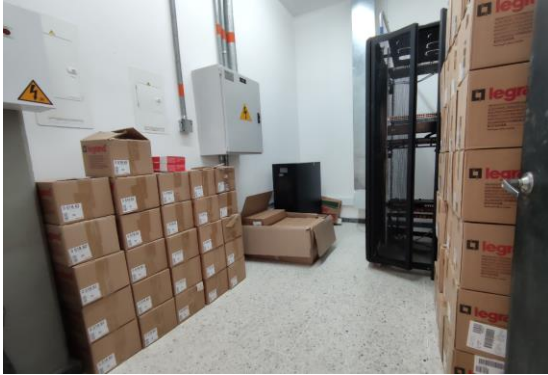
FOTO 5: Entrega de Patch cord y cables UTP
