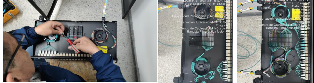
FOTO 3: Instalación de fibra óptica
