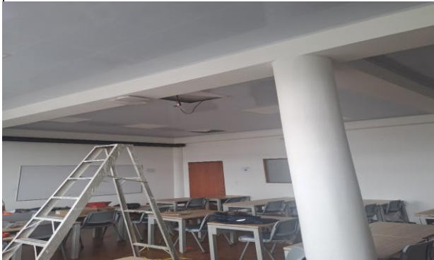
FOTO 9: Instalación Acces point en aula de Idiomas C-201 Ed. Central
