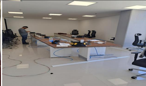
FOTO 4: Instalación cable UTP cat 6A para pto de datos en sala de juntas Rectoría Ed. Posgrados
