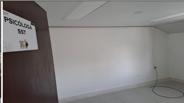
FOTO 2: Instalación canaleta plástica y cable UTP cat 6A en casa SIG, barrio la Colina
