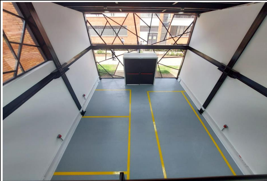
FOTO 1: Acabado y demarcación de piso nivel 1 en pintura epoxica
