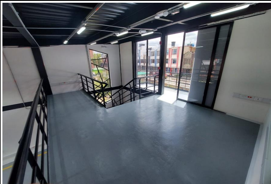
FOTO 4: Luminarias y acabado de piso mezaninne en pintura epoxica
