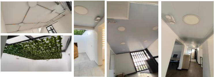
FOTO 12: Instalación de luminarias
