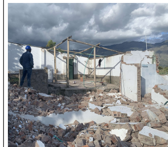
FOTO 2: Demolición de muros en ladrillo y lavadero existente
