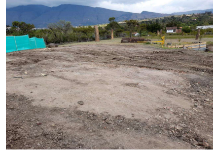
FOTO 6: Nivelación y configuración del terreno junto con la limpieza general del área de la demolición.
