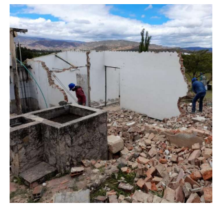
FOTO 2: Demolición de muros en ladrillo y lavadero existente
