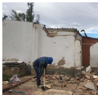
FOTO 3: Demolición de pisos, contrapisos y andenes en concreto
