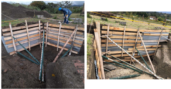
FOTO 7: Entibado en madera como sistema de protección para el personal y para estabilización temporal de las excavaciones.
