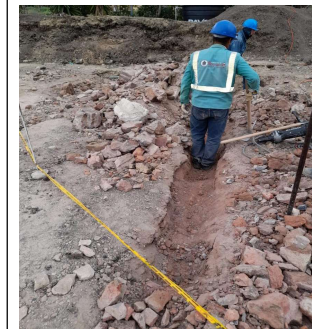
FOTO 4: Demolición de concreto ciclópeo en cimentaciones
