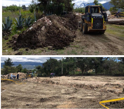
FOTO 4: Carga y transporte de material producto de la excavación y demolición, y disposición y acopio del material dentro en la zona del proyecto.
