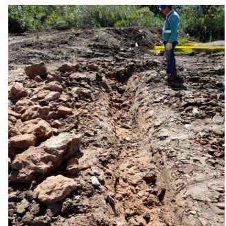
FOTO 4: Demolición de concreto ciclópeo en cimentaciones
