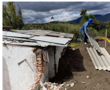
FOTO 1: Desmonte de cubiertas, ventanas, puertas y demás elementos no estructurales.
