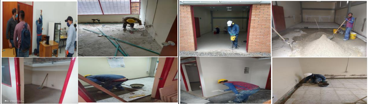
FOTO 5: ENTREGA FINAL PARTE ELECTRICA, REGATAS SOBRE MUROS, DESMONTE CIELO RASO E INSTALACION DE ENCHAFE PISO
