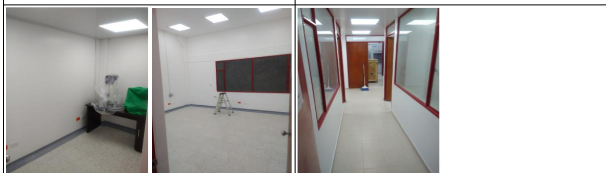
FOTO 3: ESTADO FINAL DEL AREA # 3 Y # 4 FOTO 4: CORREDOR PRINCIPAL, CAMBIO LUMINARIAS Y PINTURA.
