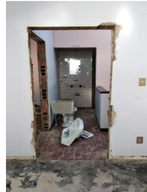
FOTO 2: Desmote de peldaños de escaleras, de marcos y puertas existentes
