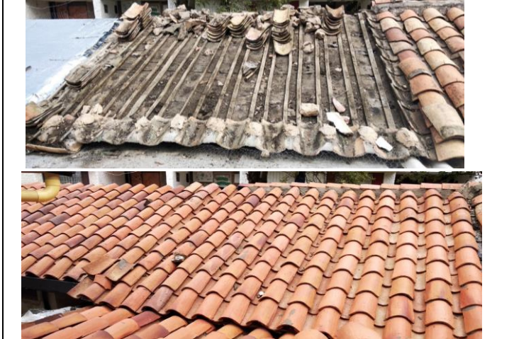
FOTO 14: Desmonte, suministro e instalacion de teja en barro
