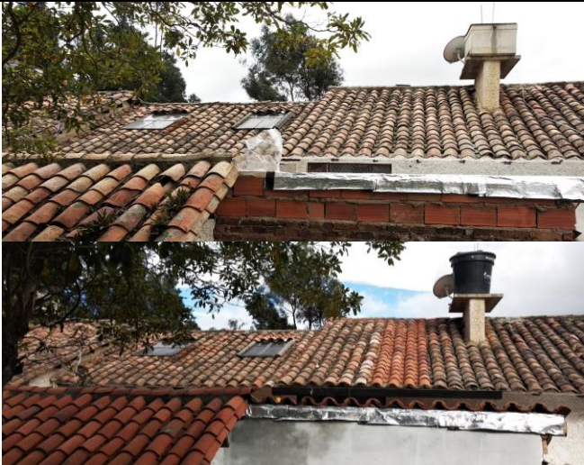
FOTO 15: Desmonte, suministro e instalacion de teja en barro y reparacion de goteras
