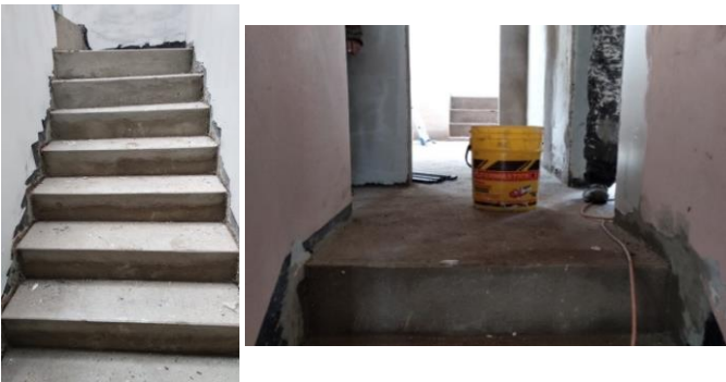
FOTO 3: Alistado y pendiente de piso con mortero 1:4 de espesor promedio de 4cm
