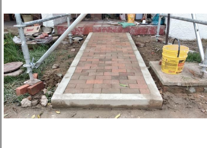
FOTO 13: Suministro e instalacion de adoquin de gres.
