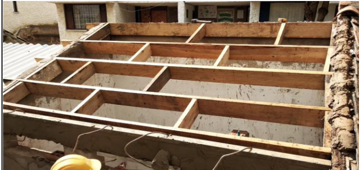
FOTO 4: Suministro e instalación de estructura en madera para montaje de teja de barro
