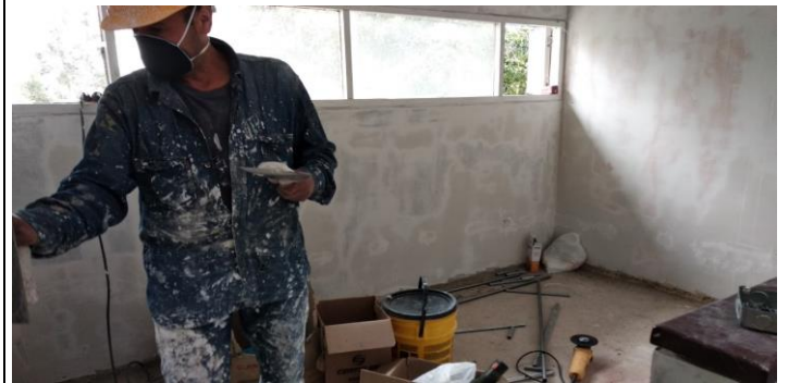
FOTO 8: Suministro y aplicación de estuco sobre muros
