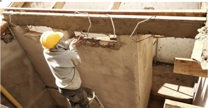
FOTO 7: Suministro y aplicación de pañete liso sobre muros 1:4
