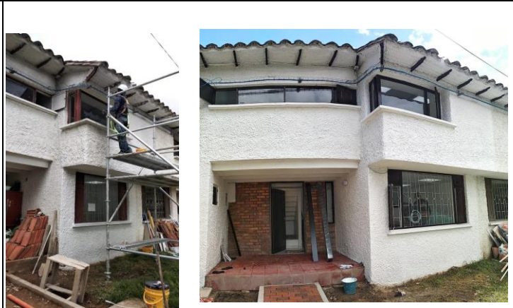
FOTO 10: Aplicación de pintura para fachada tipo koraza exteriores
