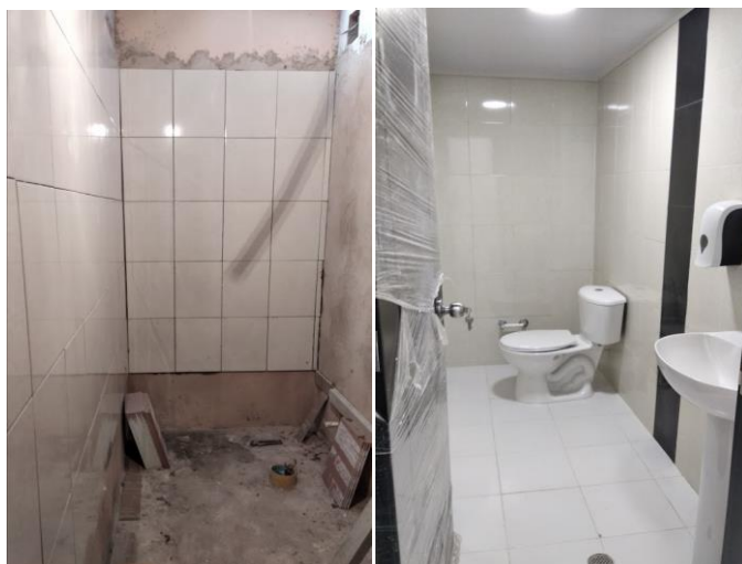
FOTO 19: Suministro e instalacion de enchape y aparatos sanitarios para baño.
