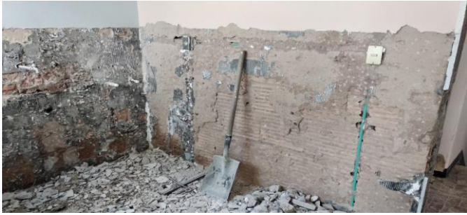
FOTO 1: Demolición de enchapes existentes
