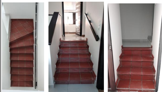
FOTO 11: Suministro en instalacion de escalgres.
