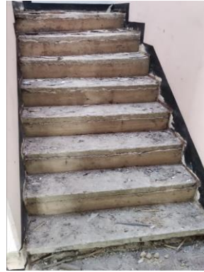
FOTO 2: Desmote de peldaños de escaleras, de marcos y puertas existentes
