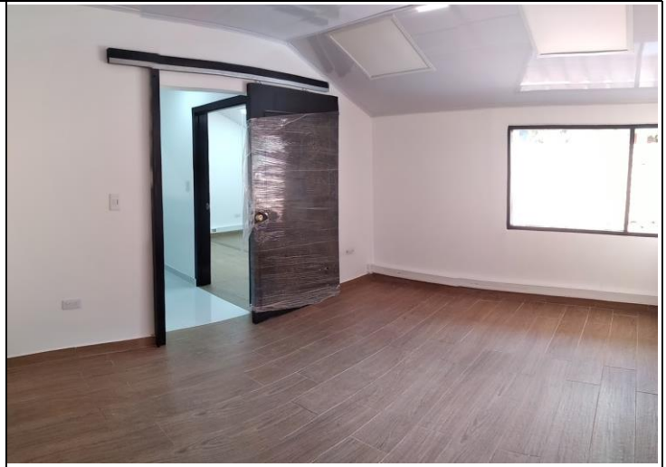
FOTO 16: Instalacion de porcelanato, estuco y vinilo en muros.
