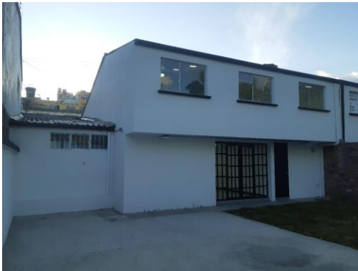
FOTO 15: Fachada posterior (después)
