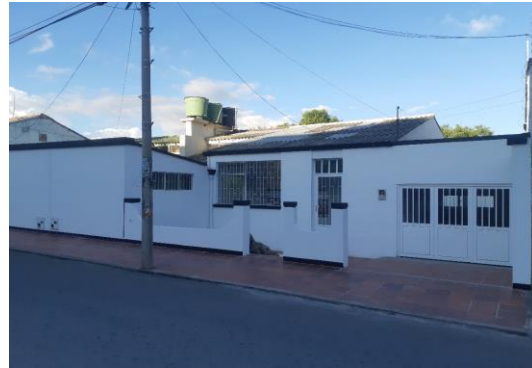
FOTO 2: Fachada principal (después)
