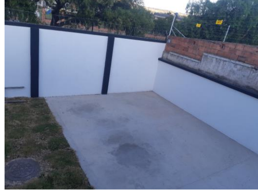
FOTO 14: Patio trasero (después)
