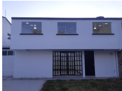
FOTO 16: Fachada posterior (después)
