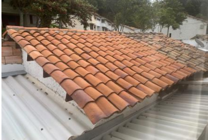
FOTO 37: CASA 3 BLOQUE 6 Cambio de teja
