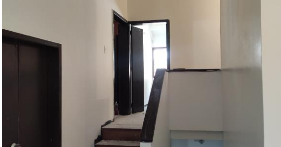
FOTO 13: CASA 2 BLOQUE 5 Pintura
