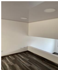
FOTO 35: CASA 3 BLOQUE 6 Suministro e instalación de piso
