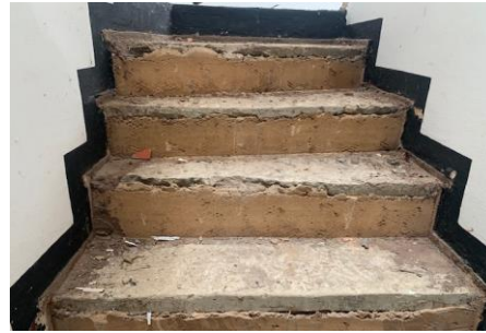
FOTO 8: CASA 3 BLOQUE 6 Demolición de enchape
