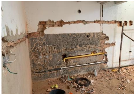
FOTO 11: CASA 3 BLOQUE 6 Instalación de tubería pvc
