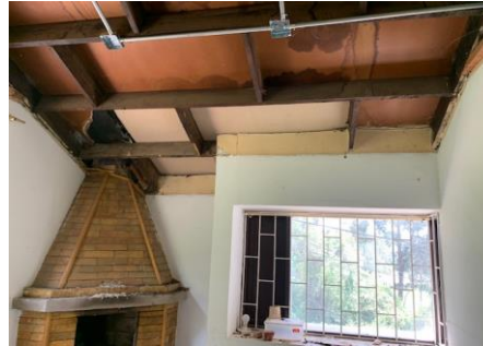
FOTO 18: CASA 1 BLOQUE 7 Suministro de cubierta
