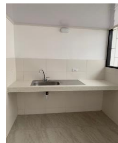
FOTO 36: CASA 3 BLOQUE 6 Suministro de mesón
