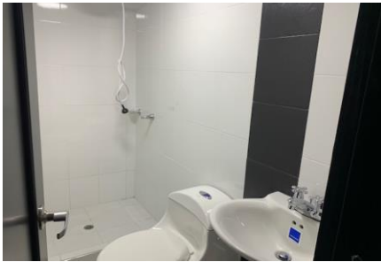
FOTO 31: CASA 3 BLOQUE 9 Suministro de sanitario
