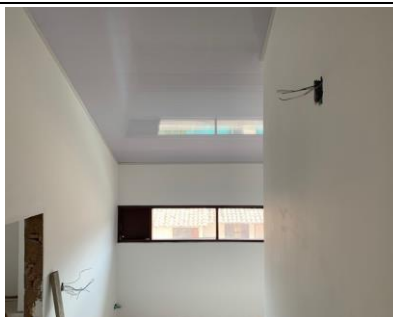
FOTO 20: CASA 3 BLOQUE 6 Suministro de cielo raso
