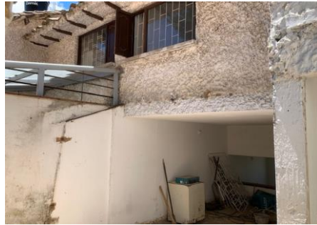
FOTO 12: CASA 1 BLOQUE 7 Demolición de muro y cubierta
