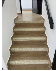
FOTO 26: CASA 3 BLOQUE 6 Suministro e instalación de piso TIPO LAKEWOOD y baranda
