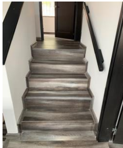
FOTO 39: CASA 3 BLOQUE 6 Suministro e instalación de piso
