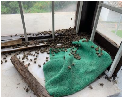
FOTO 15: CASA 1 BLOQUE 7 Desmonte de panel de abejas
