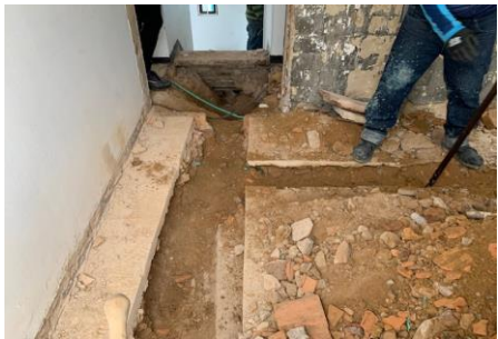
FOTO 9: CASA 3 BLOQUE 6 Cambio de tubería
