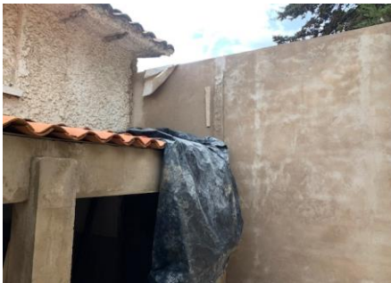
FOTO 17: CASA 3 BLOQUE 9 Demolición de muro del patio
