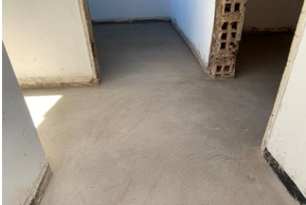
FOTO 5: CASA 3 BLOQUE 6 Alistado de piso
