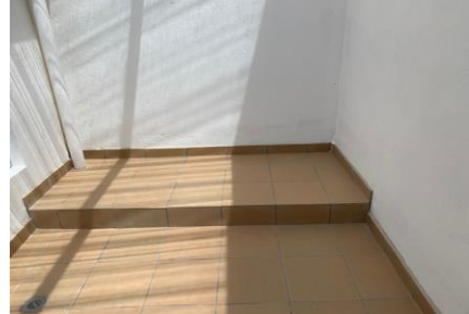
FOTO 30: CASA 3 BLOQUE 9 Instalación de piso
