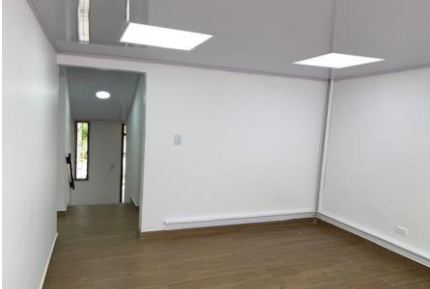
FOTO 29: CASA 3 BLOQUE 9 Instalación de canaleta para redes
