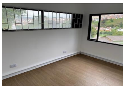
FOTO 28: CASA 3 BLOQUE 9 Cambio de ventanería
