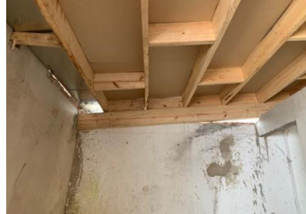
FOTO 14: CASA 1 BLOQUE 7 Suministro de estructura de madera
