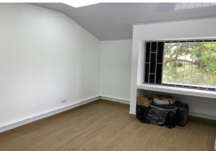
FOTO 27: CASA 3 BLOQUE 9 Instalación de canaleta para redes
