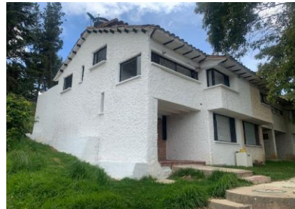
FOTO 40: CASA 3 BLOQUE 9 Pintura de fachada
