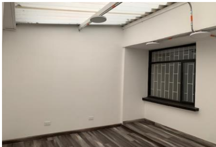
FOTO 34: CASA 3 BLOQUE 6 Suministro de luminarias
