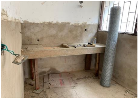
FOTO 7: CASA 3 BLOQUE 6 Construcción de placa para mesón
