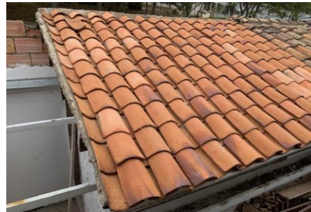
FOTO 10: CASA 3 BLOQUE 9 Suministro de teja de barro
