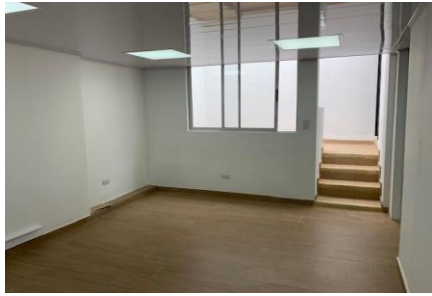
FOTO 32: CASA 3 BLOQUE 9 Suministro e instalación de luminarias
