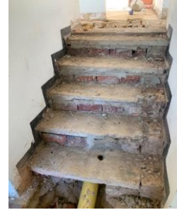
FOTO 6: CASA 3 BLOQUE 6 Instalación de tolete en contrahuella
