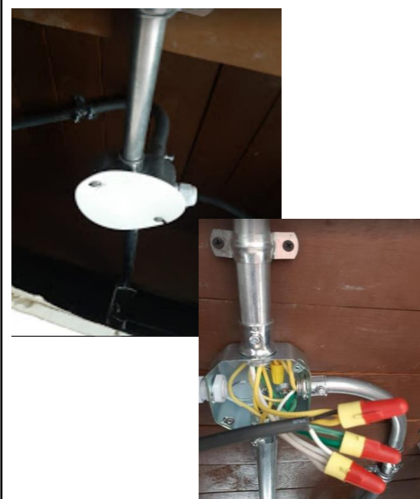
FOTO 2: Salida Monofasica y luminaria
