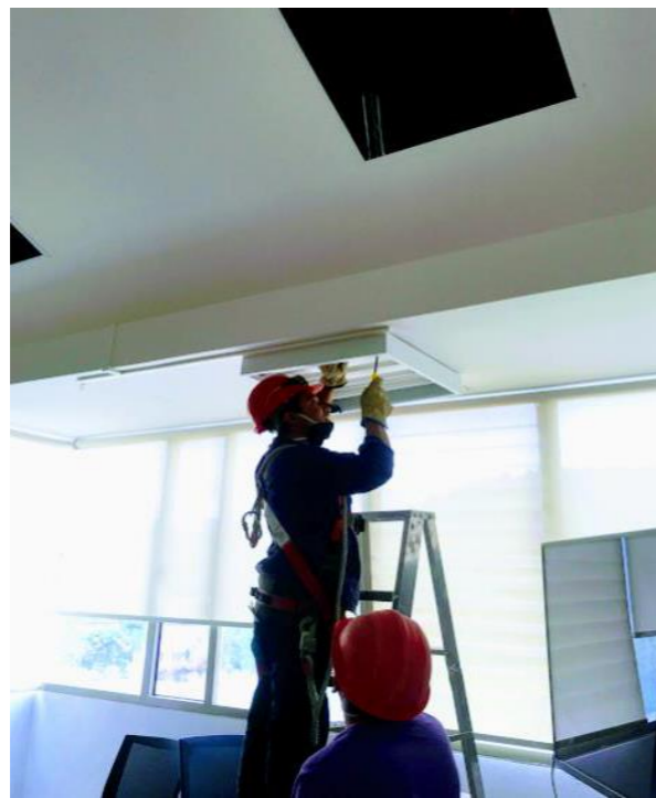
FOTO 1: Desmonte Luminarias Existentes FESAD TUNJA
