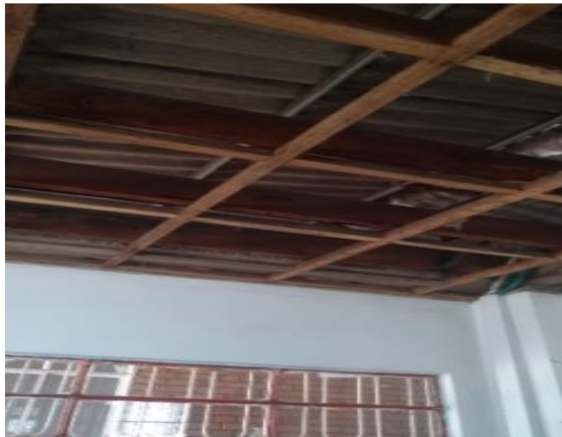
FOTO 3: Desmonte de Cielo falso CREAD DUITAMA
