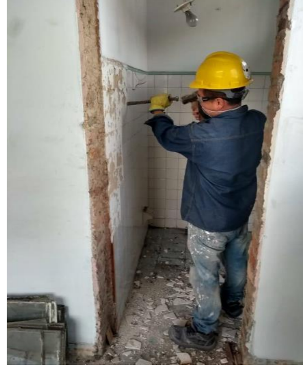
FOTO 6: Demolicion enchapes de baños
