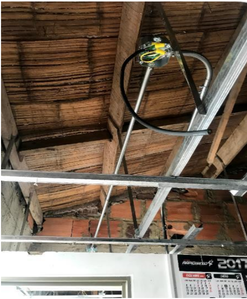
FOTO 13: salida monofasica e instalacion luminaria
