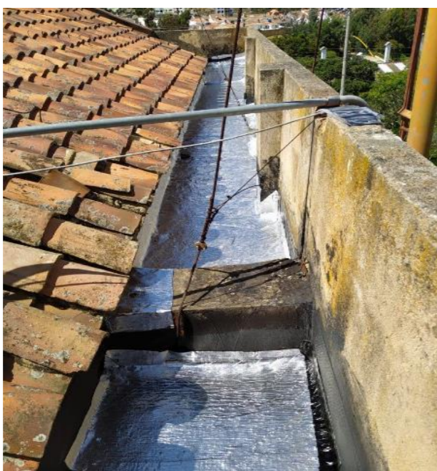
FOTO 15: impermeabilizacion canales y vigas
