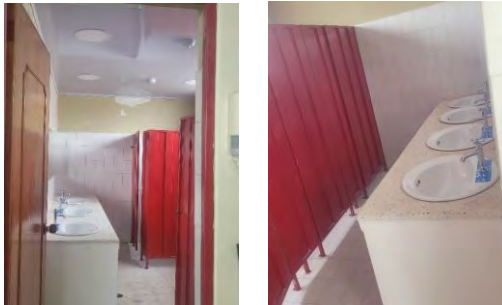
FOTO 3: SUMINISTRO E INSTALACIÓN DE LAVAMANOS, CIELO RASO Y LUMINARIAS EN BAÑOS RESTAURANTE ESTUDIANTIL
