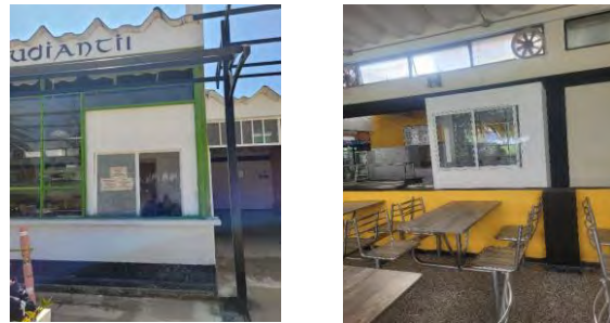
FOTO 4: CONSTRUCCIÓN CASSETAS DE COMPRA Y RECIBO DE CREDITOS RESTAURANTE ESTUDIANTIL
