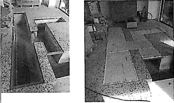
37. Instalación de piso superboard 20 mm
