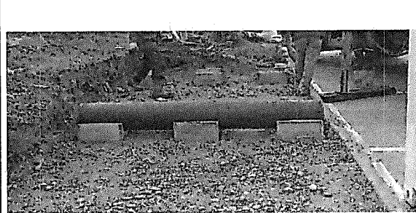
25. Corte pavimento rígido, Instalacion red hidraulica y reparacion
