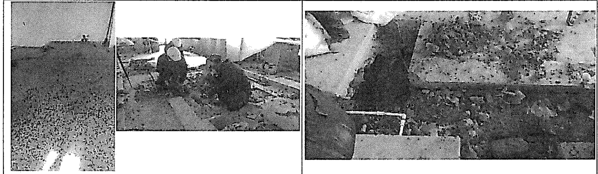
1. Demolición de piso en granito pulido 2. Demolición placa de contrapiso en concreto
