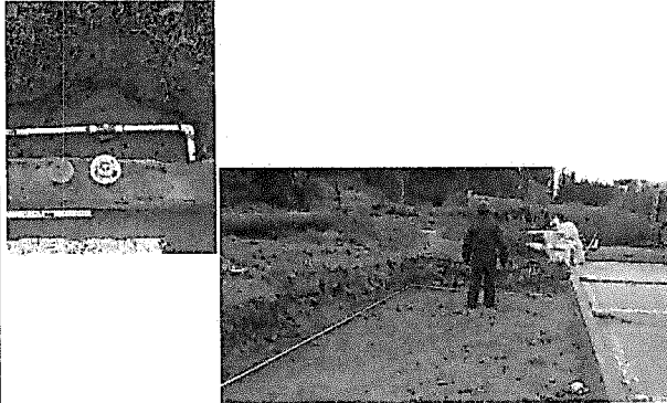
35. Suministro e instalación de registro metálico y red hidráulica
