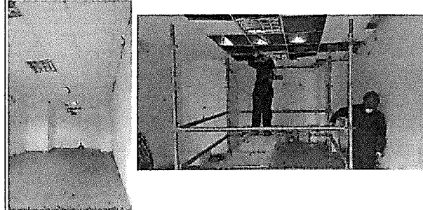
4. Demolición de mesón y desmonte de canaleta.
