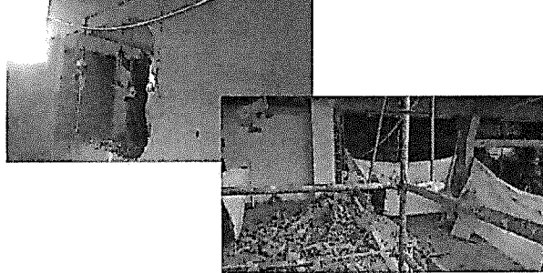
3. Demolición de mesón y cancelacion de punto hidráulico.
