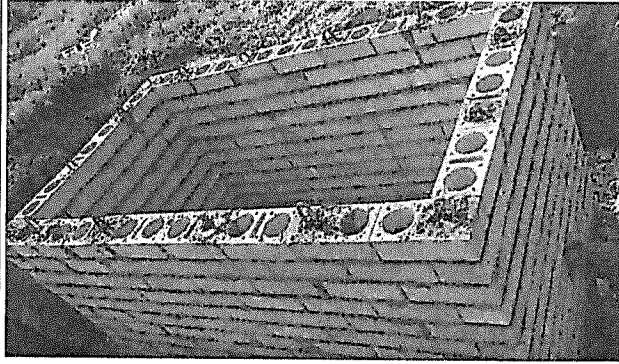
FOTO 3: CONSTRUCCION DE MUROS EN MAMPOSTERIA
