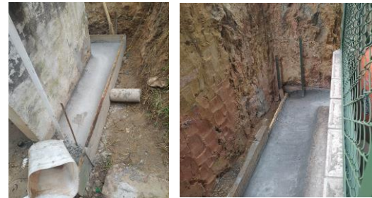
FOTO 6: Construcción de cuneta
