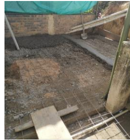
FOTO 2: Mejoramiento de piso con material de afirmado compactado y fundida de placa de piso
