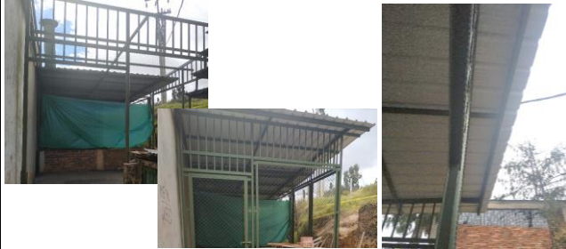
FOTO 5: Perfilera para cubierta y Suministro e instalación de teja termoacustica ecorrof
