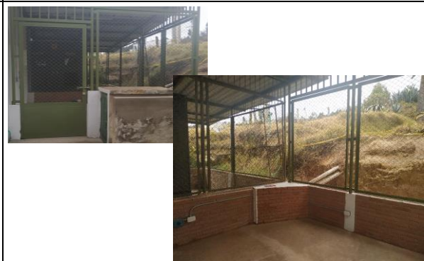
FOTO 4: Cerramiento en malla eslabonada
