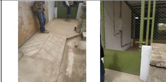
FOTO 8: Pompeyano para ingreso de compresor y bodega terminada
