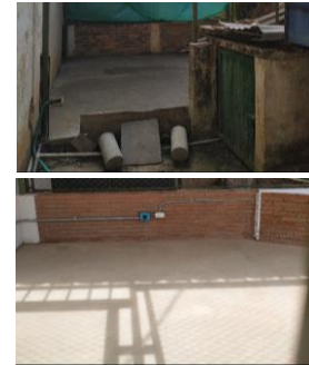
FOTO 2: Mejoramiento de piso con material de afirmado compactado y fundida de placa de piso
