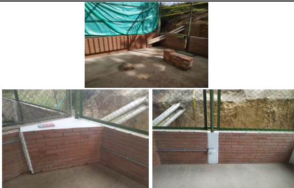
FOTO 3: Construcción de antepecho en ladrillo Santa Fe
