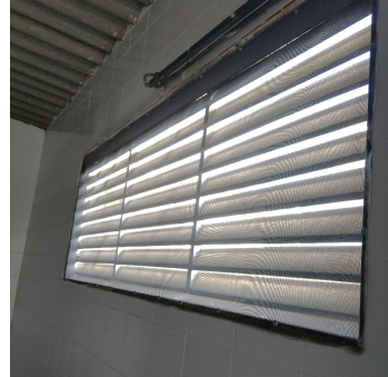
FOTO 6: Suministro e instalación de anjeos en fibra de vidrio, de alta resistencia a la corrosión y larga duración, con tejido de malla uniforme, para puertas y ventanas.
