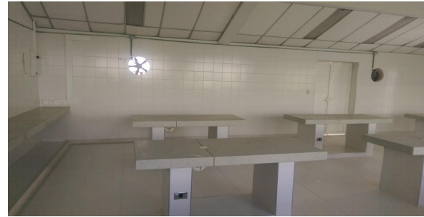
FOTO 2: Enchape de muros en baldosa cerámica (formato 20 x 20, color blanco), incluye boquilla, material de pega, mano de obra, herramienta y demas demas necesarios para la ejecución. Altura promedio 2,30 m
