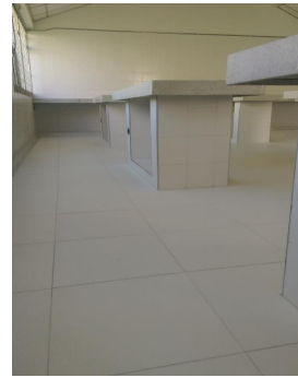
FOTO 6: Alistado y compactado de piso, suministro e instalación de piso tipo Troyano.
