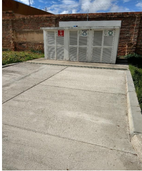
FOTO 5: LOSA MACIZA CIMIENTO CONCRETO 21 MPa - 3000 PSI H=15 CM
