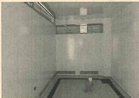
FOTO 5: Estlucos para muros internos, doble cara, incluye mano de obra herramienta, andamio de ser necesario y demas elementos para el correcta desarrollo de la actividad
