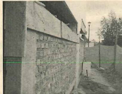
FOTO 4: Muro lotele comun e=0,12m, incluye mano de obra herramienta.
