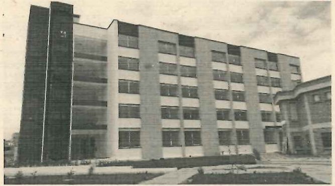
FOTO 2: VISTA GENERAL FACHADA NORTE
