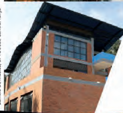
Edificio de Música, UPTC Sede Central Tunja
