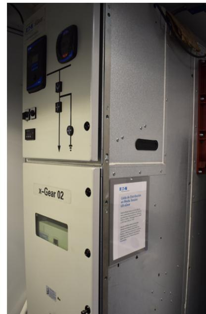
Figura 3. Celda de distribución en media tensión UX-xGear.
