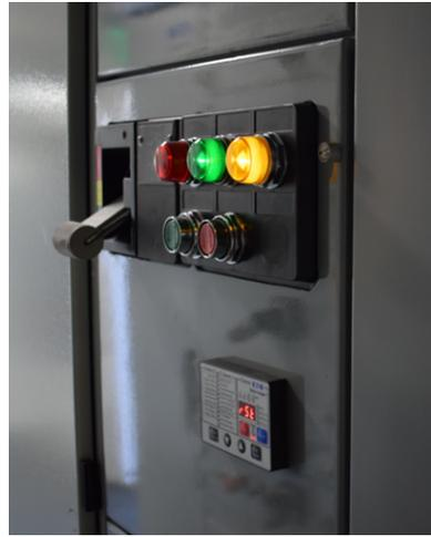
Figura 5. Centro de control de motores Freedom.
