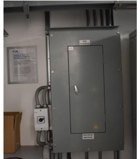
Figura 6. Sistema de control de alumbrado inteligente Pow-R-Command.
