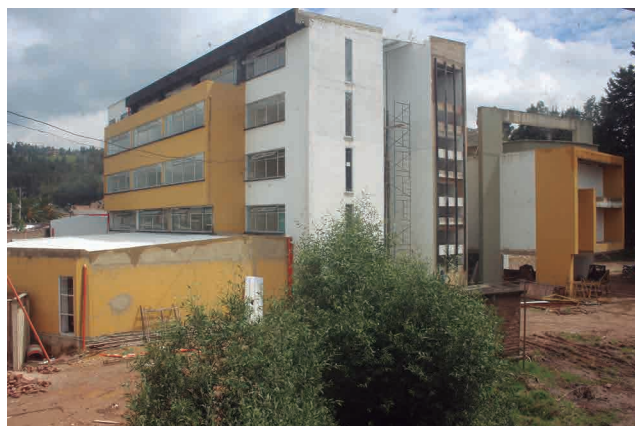
Avanzan las obras en el nuevo edificio de aulas
