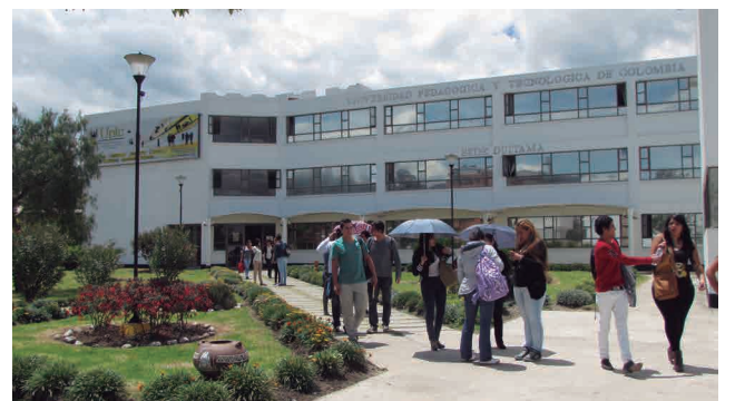
Edificio Administrativo Uptc Seccional Duitama
