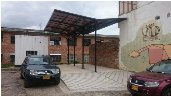
CONSTRUCCIÓN PARQUEADEROS BUSETAS Y LABORATORIOS MÓVIL
