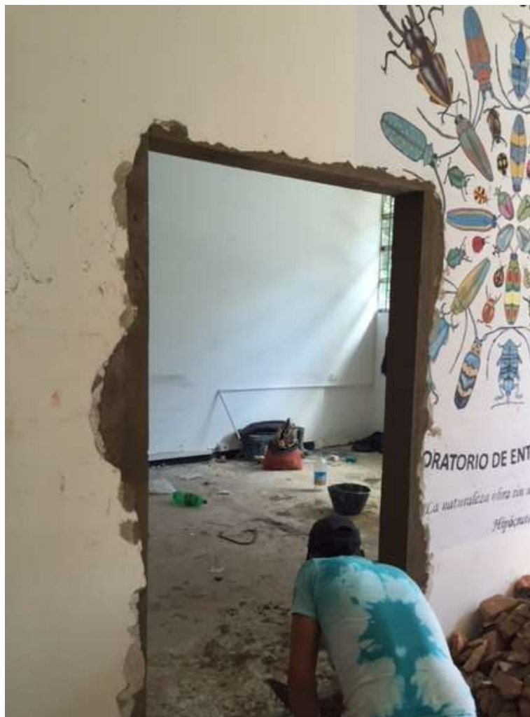
Durante la ejecución
