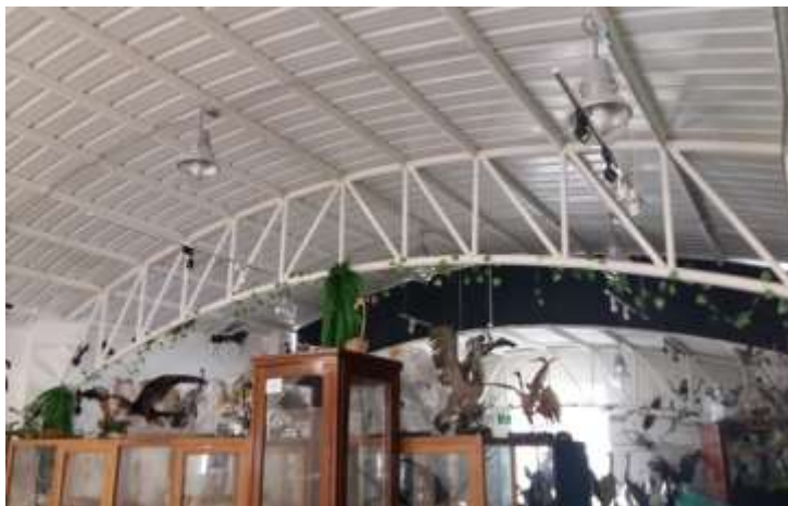
Durante la ejecución
