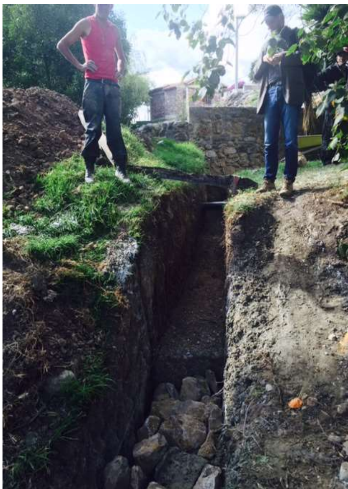
Durante la ejecución
