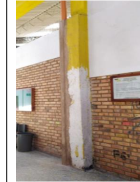
FOTO 16: Raspado Garraplast y pintura vinilo sobre columnas
