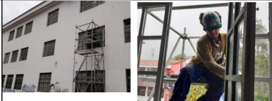
FOTOS 18: Mantenimiento y reparacion de ventanas
