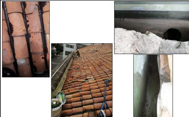
FOTO 7: Revoque de cubiertas y limpieza de canales y bajantes
