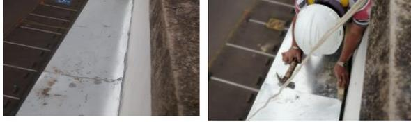
FOTO 1: Instalación de gotero en lámina
