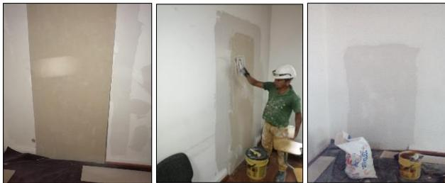
FOTO 5: Suministro e instalación de muro en superboard
