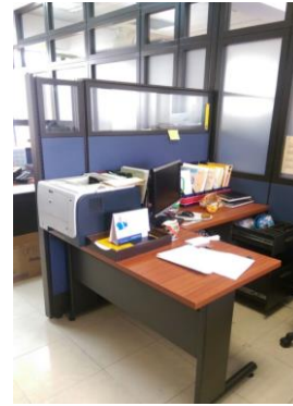
FOTO 2: Desmonte ,traslado de divisiones existentes piso a techo y media altura según diseño
