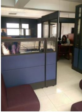
FOTO 3: Desmonte ,traslado de divisiones existentes piso a techo y media altura según diseño.
