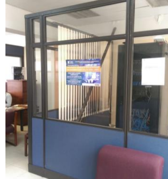
FOTO 6: Reajuste o modificación de divisiones existentes, incluye todas las actividades necesarias para su ejecución.
