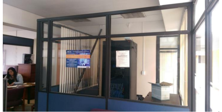
FOTO 4: Disposición de espacio para el rack y ampliación de la oficina de posgrados de ciencias económicas y administrativas.
