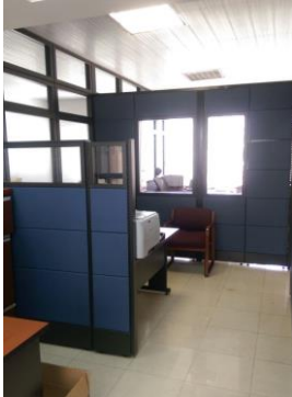
FOTO 5: traslado de divisiones existentes media altura según diseño.
