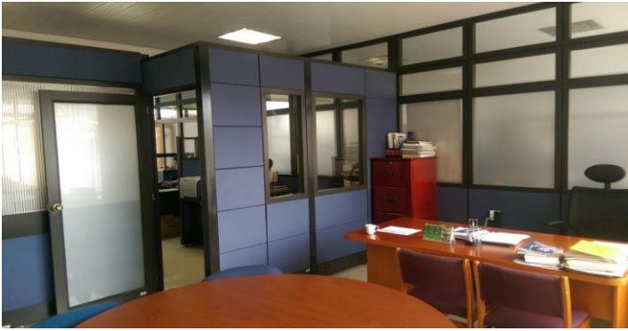
FOTO 1: Desmonte de división piso techo, incluye actividades necesarias para su ejecución.
