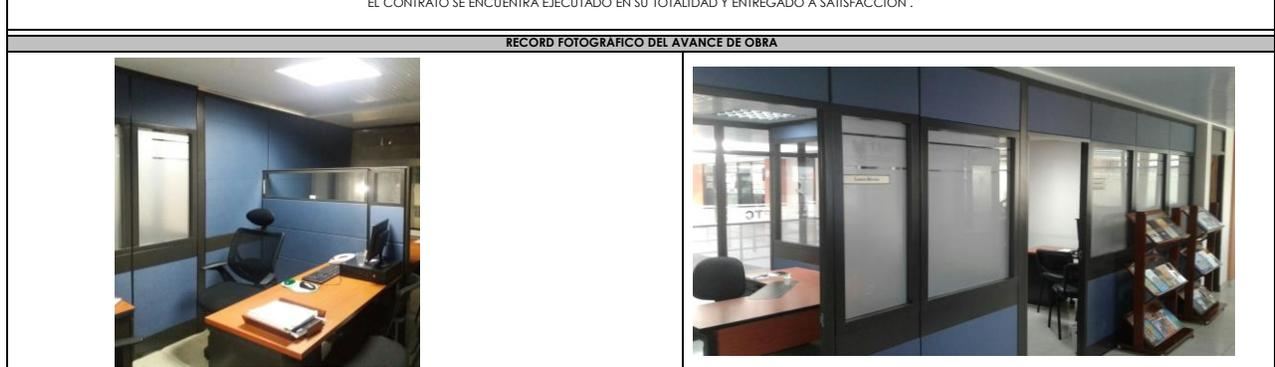
**FOTO 1:** Suministro e instalación de division en lamina cr esp 8 cms y /o similar, altura variable, Características: elaborada en lamina de acero cr. Cal 22/16 acabados con pintura en polvo epoxipoliester de aplicación electrostática color nopa.
