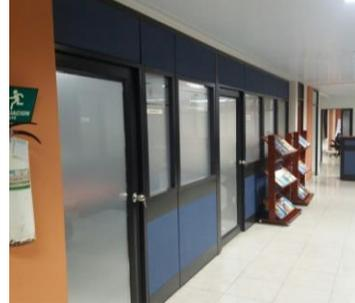
**FOTO 4:** Suministro e instalación de division en lamina cr esp 8 cms y /o similar en espesor con la que unificará). Altura variable. Características: elaborada en lamina de acero cr. Cal 22/16 acabados con pintura en polvo epoxipoliéster de aplicación electrostatica color nopal.
