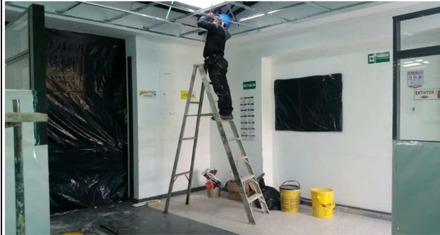
FOTO 3: Instalación de cielo raso
