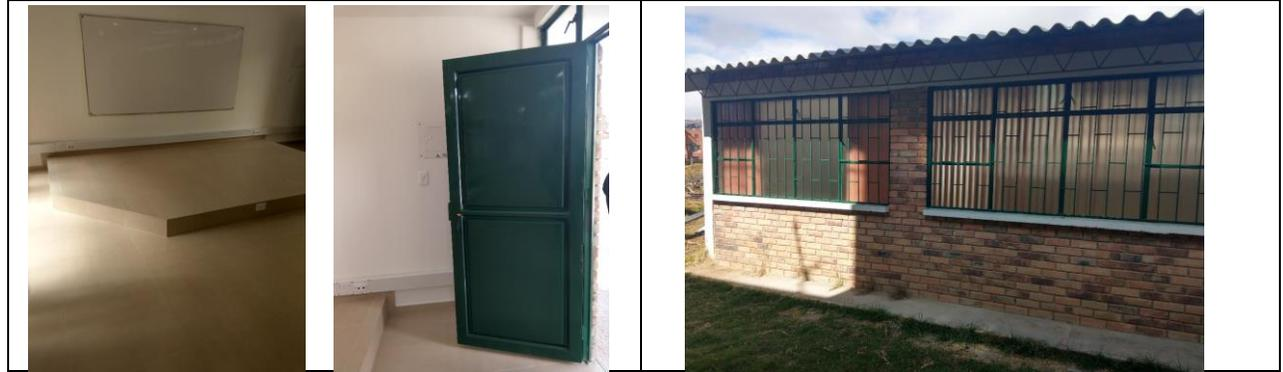
**FOTO 1:** Suministro e instalación de piso terminado en Porcelanato tipo mónico o similar, formato 60 x60 antideslizante. Y Elaboración e instalación de puerta y marco (2,10x0,91) metálico Cal.18
