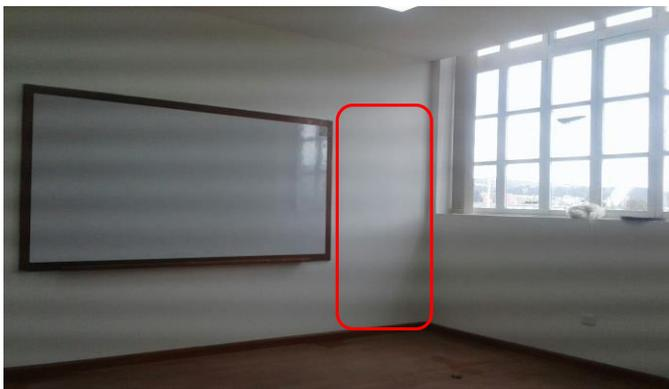
FOTO 3: Muro en Superboard Divisorio entre los salones C102 y C103.
