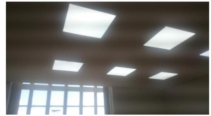
FOTO 6: Suministro e instalación de luminarias de 60x60, salón C103.
