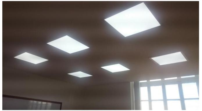
FOTO 2: Suministro e instalación de luminarias de 60x60, salón C102.
