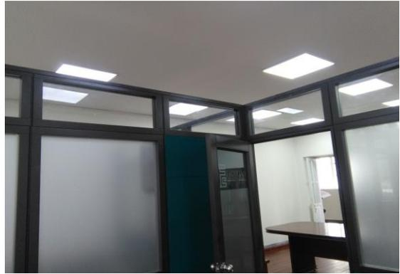
FOTO 4: Instalación de paneles tipo led.
