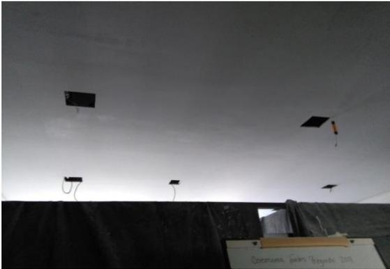
FOTO 1: Instalación de cielo raso en dry wall.
