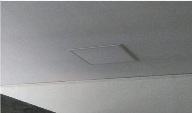
FOTO 3: Instalación de panel tipo led.
