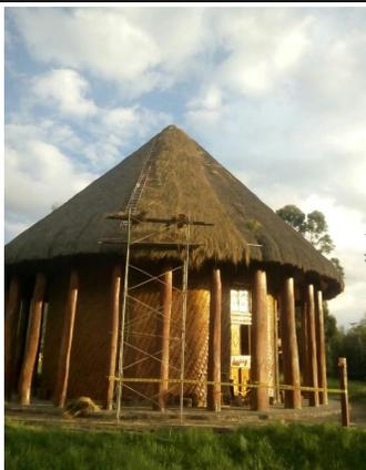
FOTO 3: Reempaje de Cubierta
