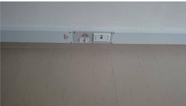
FOTO 5: Instalación de puntos de datos salones L-407,L-408,L-409 y L-410.
