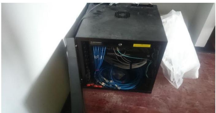
FOTO 6: Suministro e instalación de switch de 24 puertos HP 2500E con 2 tarjetas de stacking 10 Gb y cable de stack en cuarto del RACK.
