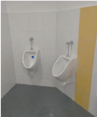
FOTO 5: Suministro e instalación de orinal tipo institucional REF. ARRECIFE, color blanco, incluye grifería antibandalica, mano de obra y equipo necesario para su instalación
