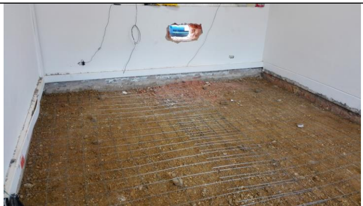
FOTO 4: TRASLAPE DE MALLA SOBRE BASE COMPACTADA
