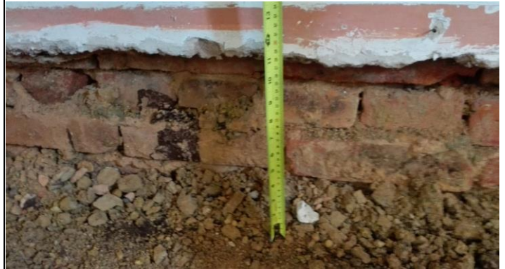
FOTO 2: PROFUNDIDAD EXCAVADA PAR DESPLANTE DE LA PLACA
