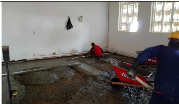
FOTO 5: COLOCACION DE CONCRETO DE PLACA REFORZADA
