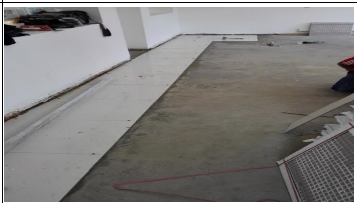
FOTO 6: COLOCACION DE CERAMICA SOBRE PLACA
