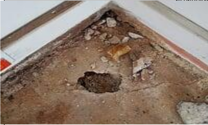
FOTO 1: SONDEO DE PISOS PARA DETECTAR ESTADO INICIAL
