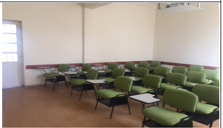
FOTO 4: SALONES TERMINADOS CON PIRLAN EN MADERA PARA PROTECCION DE LA PARED
