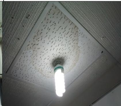
**Fotografía 52 Filtración de agua por los techos, sobre la parte eléctrica - Sogamoso**
