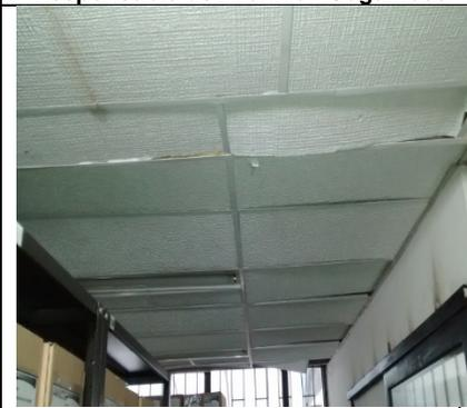
**Fotografía 51 Techos en mal estado, cableado eléctrico por fuera - Sogamoso**
