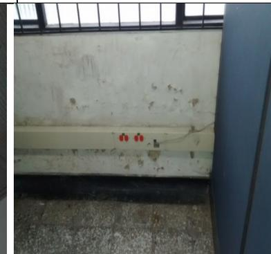
**Fotografía 53: Paredes con humedad - Sogamoso**
