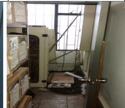
**Fotografía 54: gabinete "rack de comunicación, cableado eléctrico suelto por el piso - Sogamoso**
