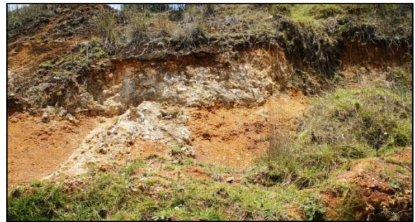
Figura 1. Talud para ser evaluado.
