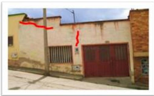
**Figura 5.** Agrietamiento en los muros de carga
