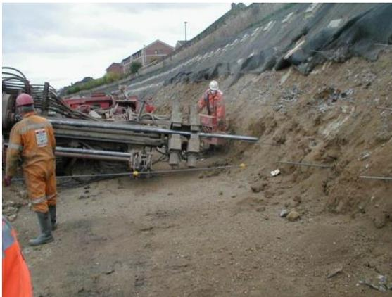
Especial interés presenta el sistema de FRP que permite, mediante el anclaje de tubos tipo "manguito" la densificación de los suelos. Se presenta como metodología muy útil para hacer inyecciones alrededor de edificaciones existentes, cuando se requiere hacer perforaciones cercanas, por ejemplo para desarrollo de sistemas de metro, redes hidráulicas, pozos, etc.
