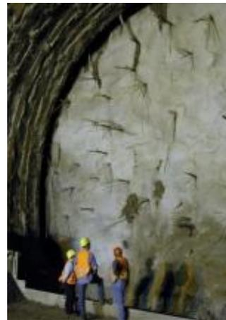
El sistema de anclajes en el terreno se facilita por su bajo peso, alta resistencia y sobre todo por su alta resistencia a la corrosión, que da garantías para su durabilidad. Las metodologías de diseño son muy consecuentes con las formulaciones usadas en la mecánica de suelos para la estabilidad de los taludes o sostenimiento de muros pantallas. Los criterios sobre los coeficientes de reducción de su capacidad son iguales a los descritos anteriormente para otros reforzamientos.
