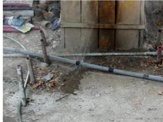
Finalmente, y teniendo en cuenta las ventajas que no se encuentran en otros materiales, se ha visto bastante adecuado por su facilidad de ejecución, rapidez, y durabilidad, hacer inyecciones de tuberías en FRP en los taludes, para que funcionen como filtros horizontales. Aplicación efectiva y duradera, que por esto ofrece resultados de buen rendimiento económico en el tiempo.
