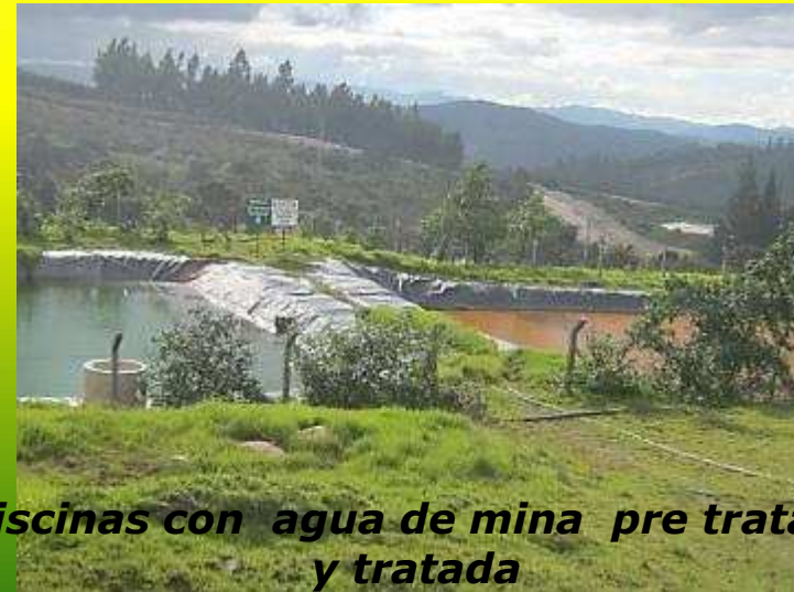
Piscinas de sedimentación para aguas de escorrentía y finos en patios de almacenamiento
